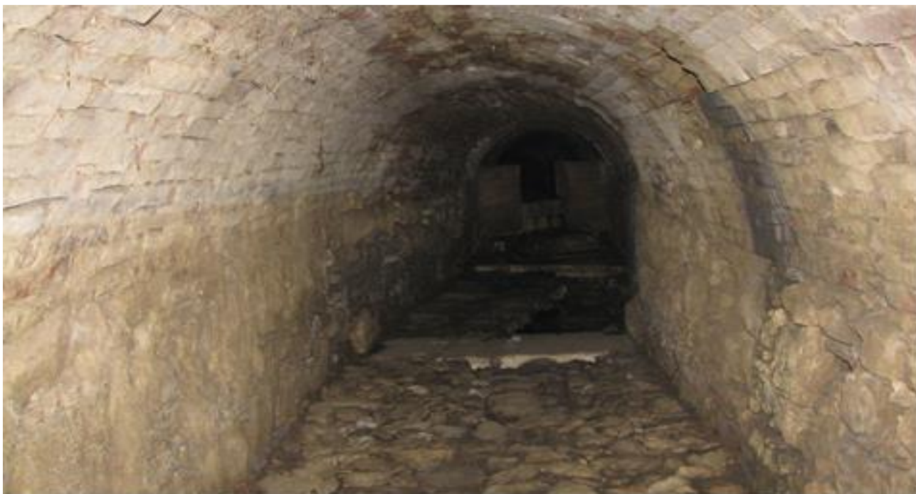
Condotto di scarico della fognatura che scende da contrà delle Grazie e sfocia nel Retrone all'inizio di viale Ereterio. Il piano di scorrimento delle acque è costituito dalla strada di cui al n. 20 della tabella cronologica sopra riportata. Fotografia di Adolfo Trevisan e Carlo Masolo 2016
